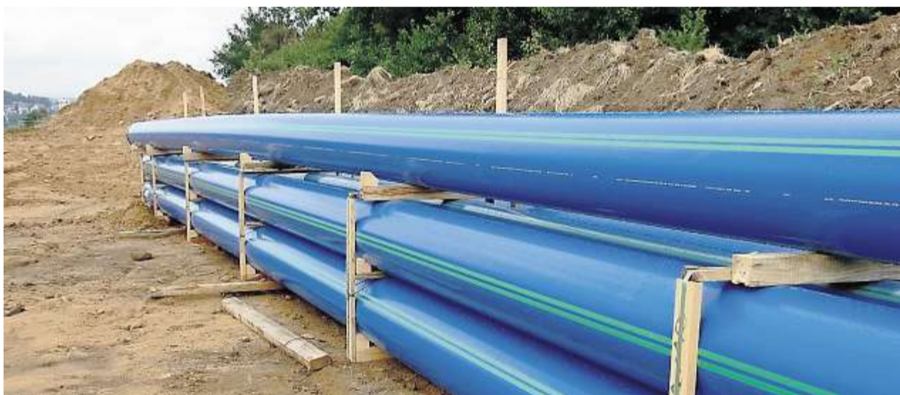
Die Rohre haben einen Durchmesser von 40 Zentimetern. Durch sie wird künftig das Wasser in die Kreisstadt fließen.
