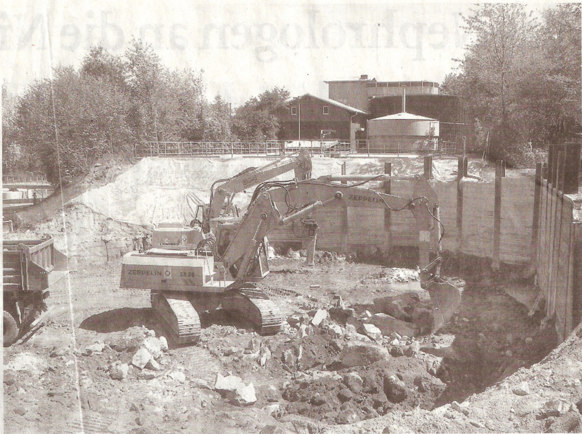
Hier entsteht der neue Schlamm-polder für das Klärwerk.
