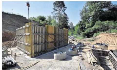
Links ist die Schalung für die Brückenfügel zu erkennen, dahinter in der Bildmitte der Radweg, über den diese Brücke einmal führen wird. Bild: Stephan Huber
