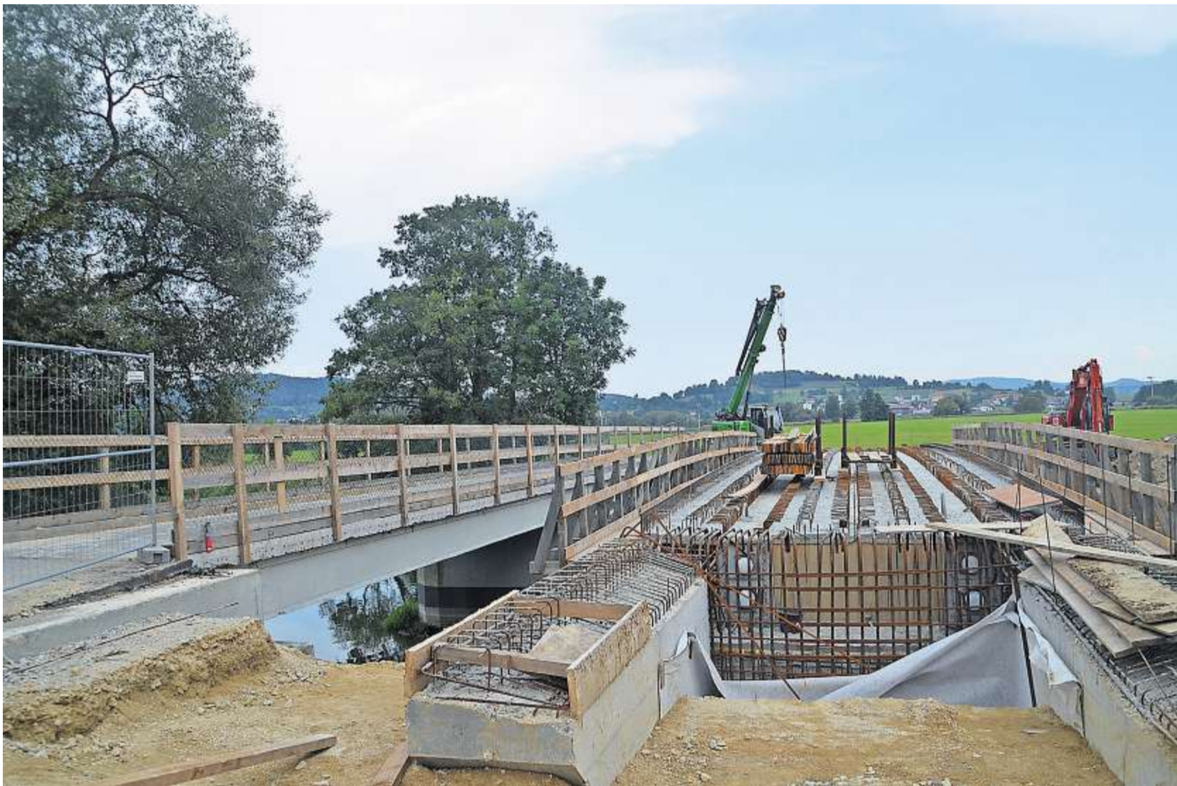
So sieht das Innenleben einer Brücke aus. Bis November soll das neue Tragwerk fertig sein.
