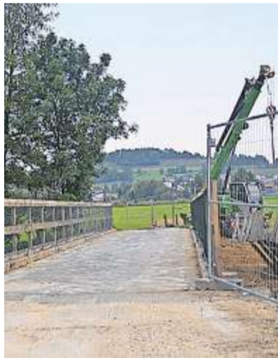
Die alte Chambrücke wird nach dem Neubau zurückgebaut.
