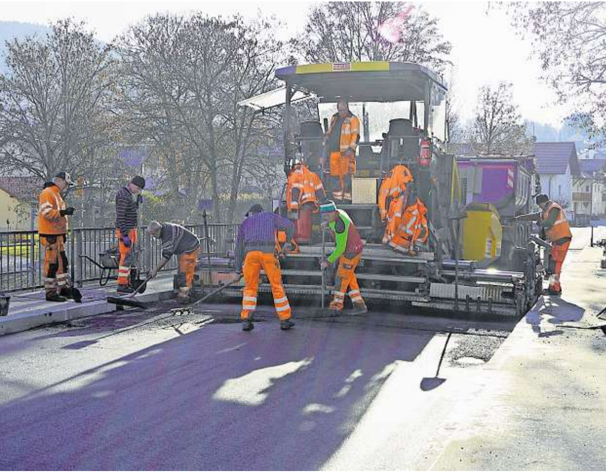
Vor wenigen Tagen wurde durch die Firma Strabag das Bauwerk mit dem Einbau der Asphalt-Deckschicht wieder versiegelt.
