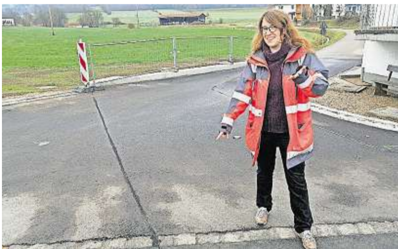
Die Fuge markiert den Verlauf des unterirdischen Tunnels.
