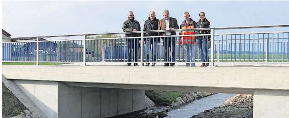
Ein imposantes Bauwerk – die neue Brücke über den Rötzbach mit seinem blauen Geländer
