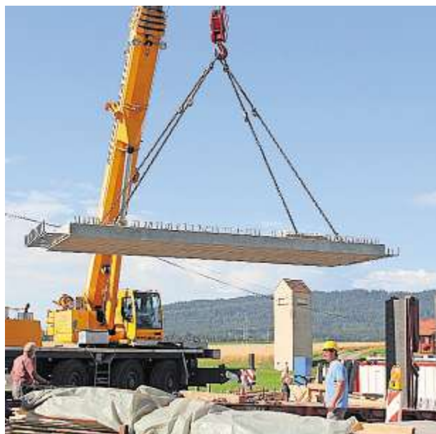
Das letzte Bauteil der Brücke schwebt ein.
