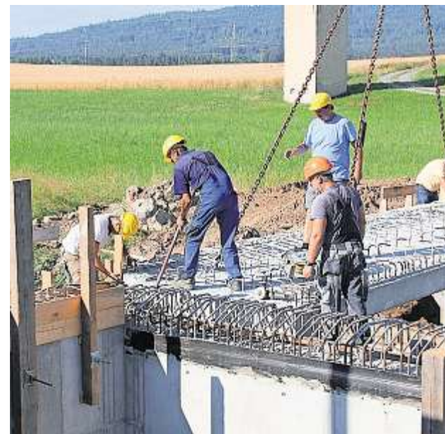
Das erste Brückenteil sitzt.
