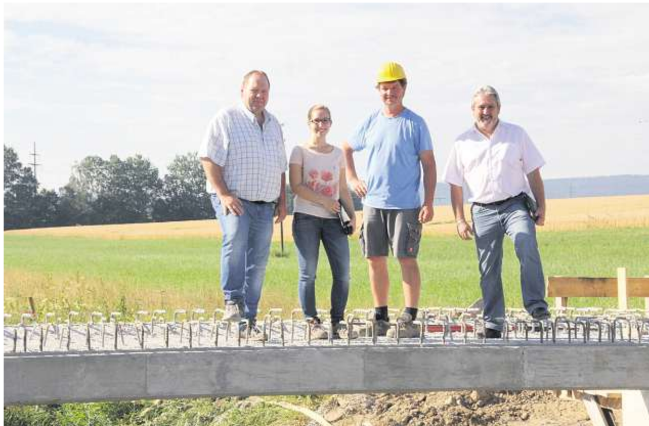
Das erste Bauteil ist eingebracht und es trägt. Davon überzeugten sich Bauleiter Ralf Mölders, Lena Kammermeier, Vorarbeiter Alexander Grotz und Bürgermeister Ludwig Reger (v.l.). Fotos: Bucher
