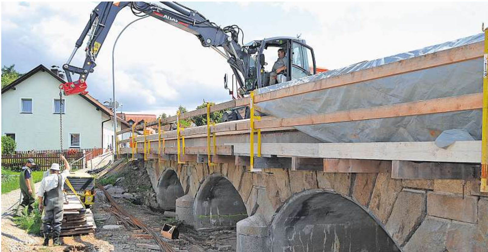
Ein Gewölbe, in dem sich die Handwerkskunst vergangener Generationen widerspiegelt: die denkmalgeschützte Brücke in Untertraubenbach.
