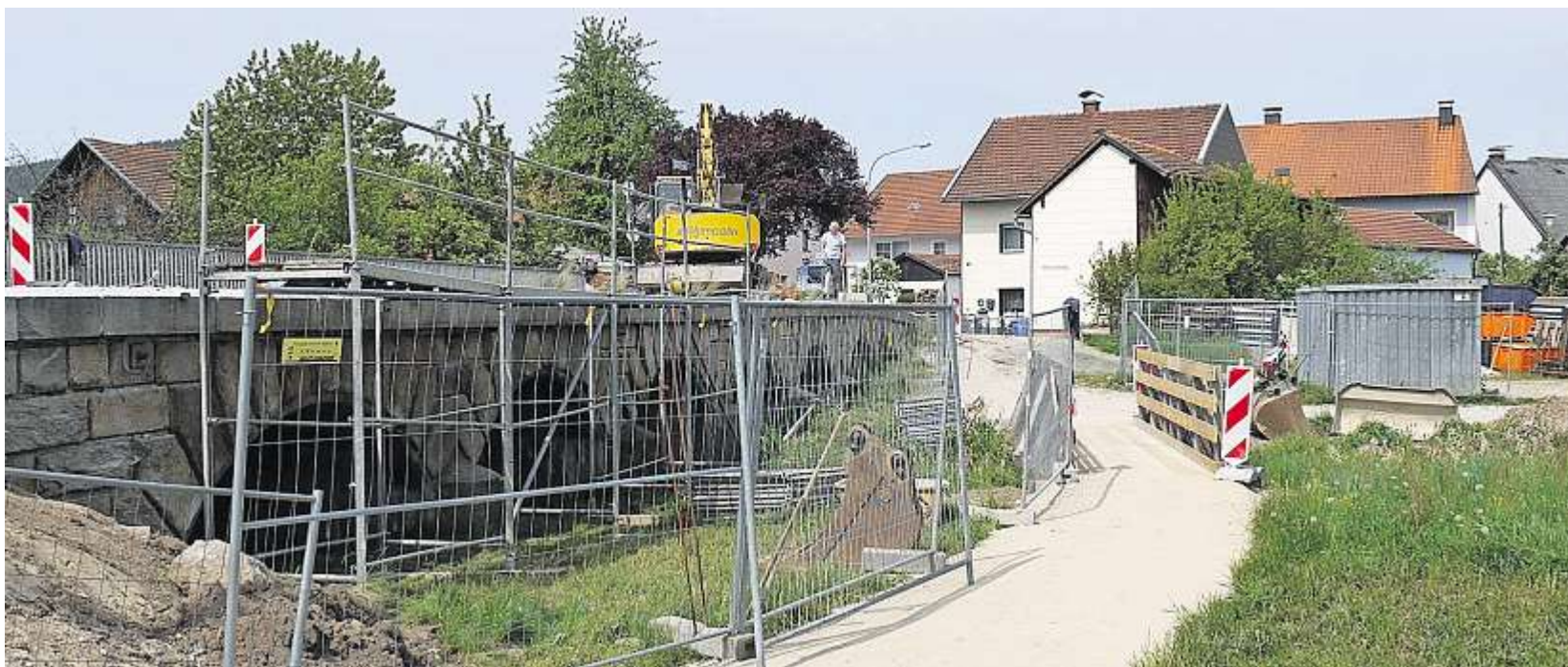
Der angelegte Fußweg mit Behelfsbrücke über den Altbach gestattet Fußgängern den Weg in das und aus dem Dorf.
