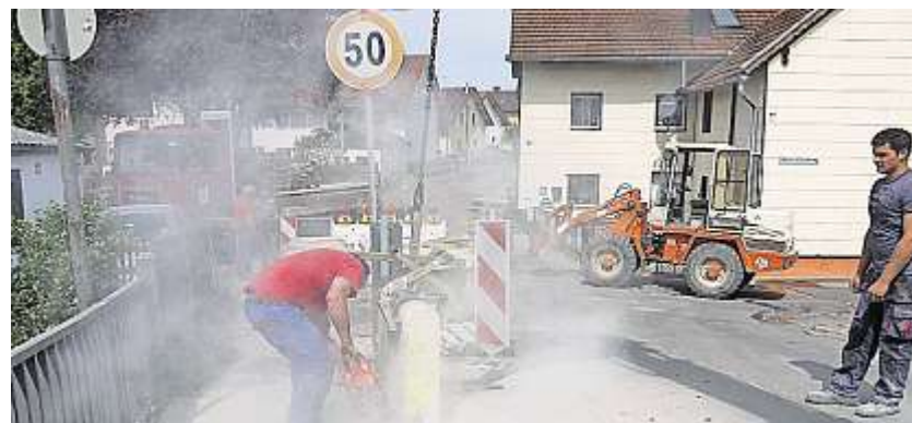
Die 20 Zentimeter dicken, 80 Zentimeter hohen Granitplatten der Brückenbegrenzung ohne Beschädigung zu entfernen, ist eine staubige Angelegenheit.
