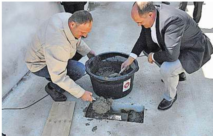
Baufirmen-Chef Hans Wutz und Architekt Bernd Spengler betonierten den Grundstein ein.
