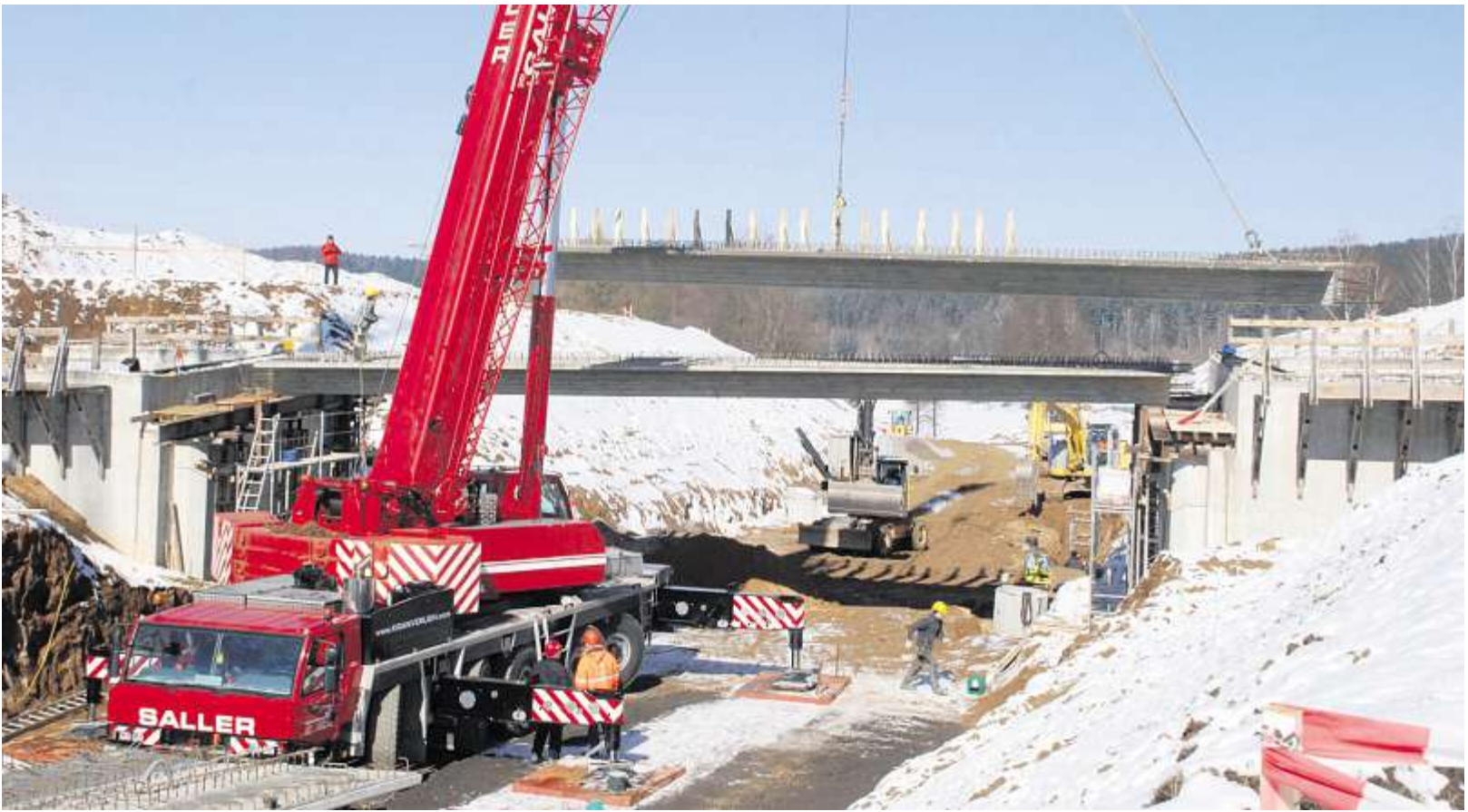
Ein tonnenschweres Brückenteil ist auf der Perlseestraße am Kranhaken unterwegs zu den vorbereiteten Widerlagern der Umgehungsstraße. Fotos: Hiob
