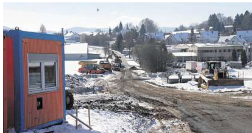
Die Restarbeiten an der Perlseestraße laufen derzeit gut voran.
