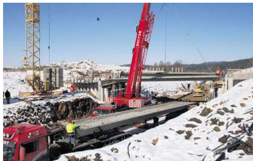
Millimetergenau wurde das Brückenteil auf dem Fundament eingepasst.
