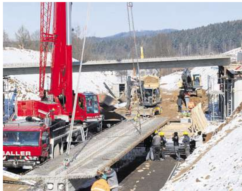
Sorgfältig vorbereitet wurden die Teile vor ihrem „Flug“ auf die Brücke.
